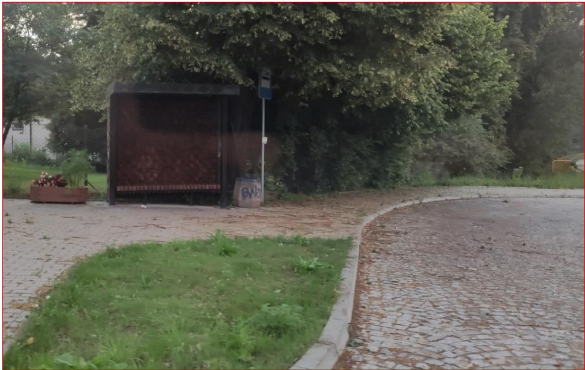
Rysunek 7.7 Inny przykład infrastruktury punktowej wymagającej modernizacji
