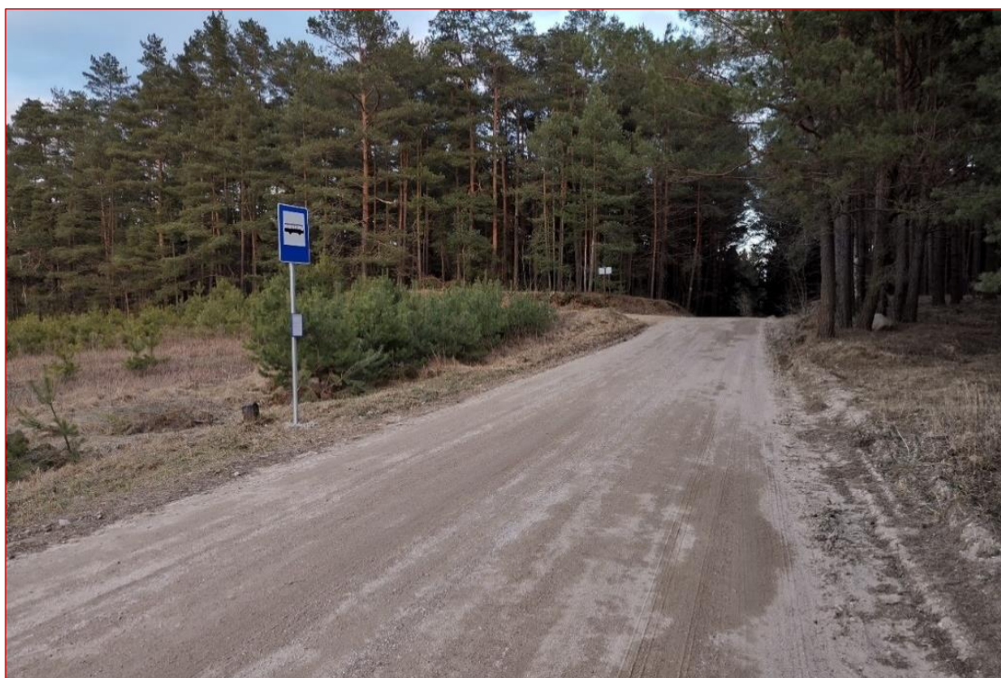
Rysunek 7.6 Infrastruktura punktowa wymagająca modernizacji
