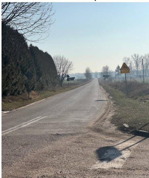
Rysunek 27. Braki w infrastrukturze drogowej i pieszej – droga w kierunku stadionu (Turośń Kościelna)
