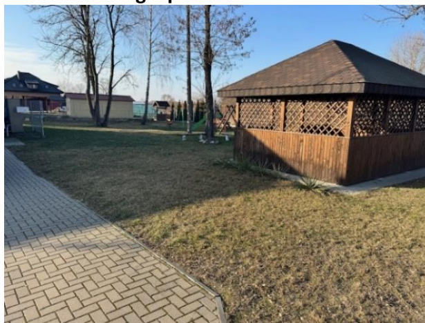
Rysunek 26. Otoczenie przy budynku świetlicy w Iwanówce – niska jakość urządzeń, braki w zagospodarowaniu terenu.
